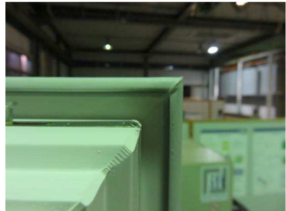
Bild 3 Innere Anschlagdichtung, Eckausbildung
