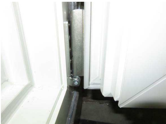
Bild 4 Ecklager, Falzansicht
