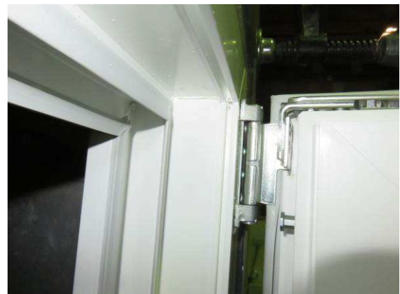
Bild 5 Scherenlager, Falzansicht
