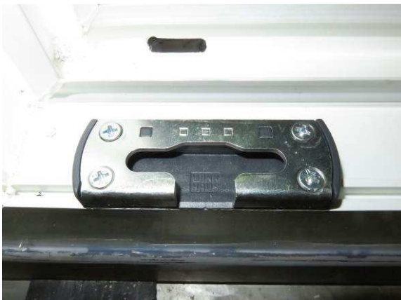
Bild 10 Verriegelungssituation Blendrahmen, Pos. 2
