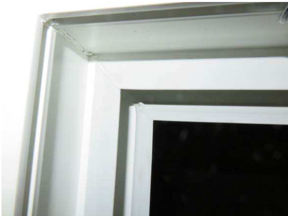
Bild 2 Äußere Anschlagdichtung und Mitteldichtung, Eckausbildung
